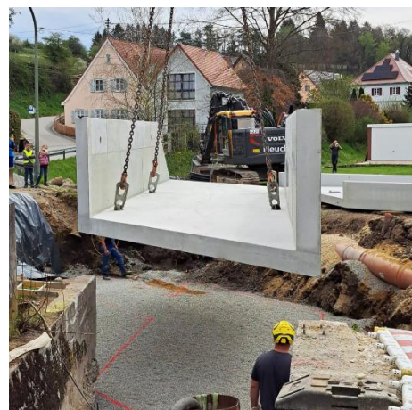
Einsetzen des Fertigbetonteils bei der Brücke im Kapellenweg
